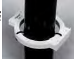
Монтаж на кабелях среднего напряжения
